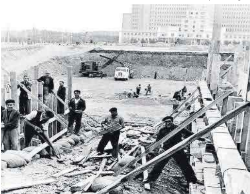
Un grupo de obreros inicia la construcción de La Romareda en 1956.
